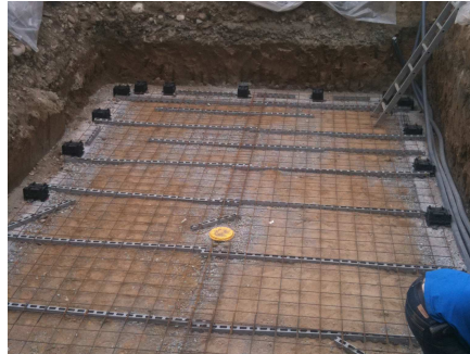
Streifenfundament / Füsse / Bodenarmierung
