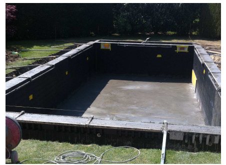
Fertig betoniertes Becken
