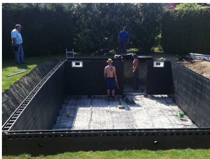
Ganzes Becken zusammengebaut
