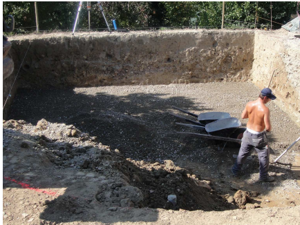
Aushub für das Becken erstellen
