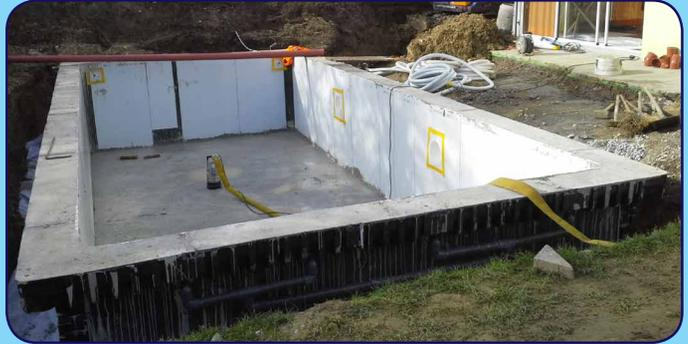
Fertig betoniertes Becken mit 30 cm Auflagerand
