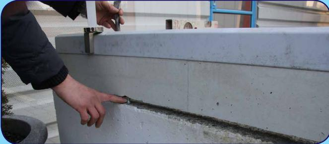
Rinne setzen und mit den Schrauben einnivellieren
