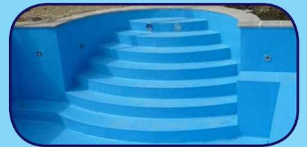
Folienauskleidung fertig verlegt
