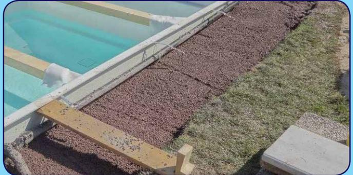
Hinterfüllung mit Spezial-Isolation
