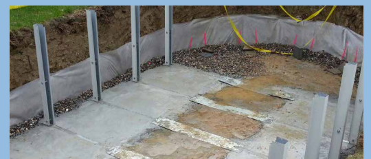
Spezielles Ovalbecken: Einbetonieren der seitlichen Stützen
