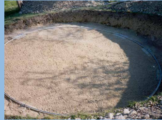
Bodenschiene verlegen
