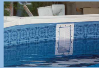
Skimmer und Düsen montieren
