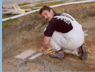
Platten ins Blei setzen
