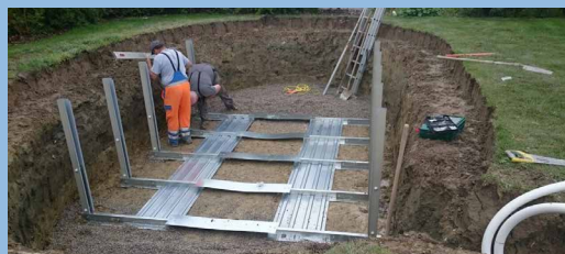
Spezielles Ovalbecken: Seitliche Stützen zusammenbauen
