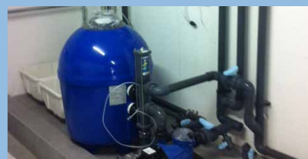
Technik im Keller
