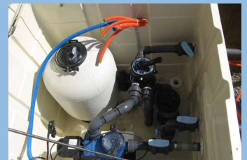
Montage der Filtertechnik.
