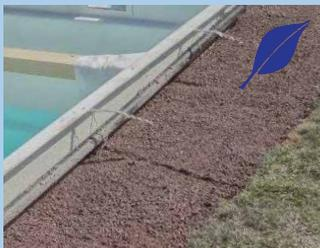
Variante 2: Hinterfüllen mit Flüssig-Isolation für einen Energiespar-Pool
