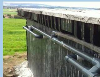
Montieren der Verrohrung, geschützt unter der Verbreiterung
